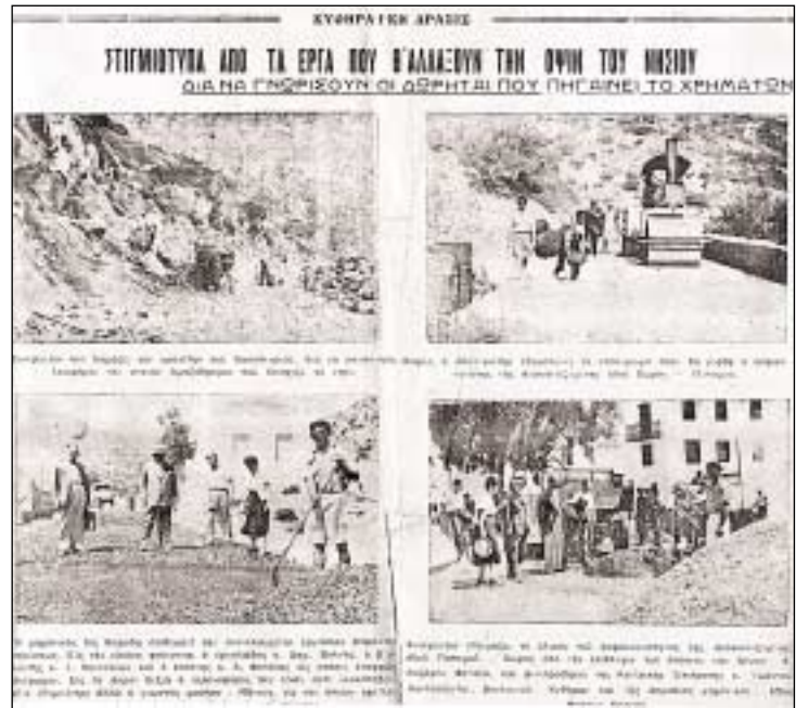
Την 10ετία το 1950 έγινε η ασφαλτόστρωση του δρόμου Χώρας - Ποταμού αρχίζοντας από τη Χώρα. Οι φωτογραφίες από την «ΚΥΘΗΡΑΪΚΗ ΔΡΑΣΗ», εφημερίδα της εποχής. Η διαπλάτυνση του δρόμου στο βραχώδες «Κακοπέτρι» ήταν από τα σημαντικότερα έργα.
